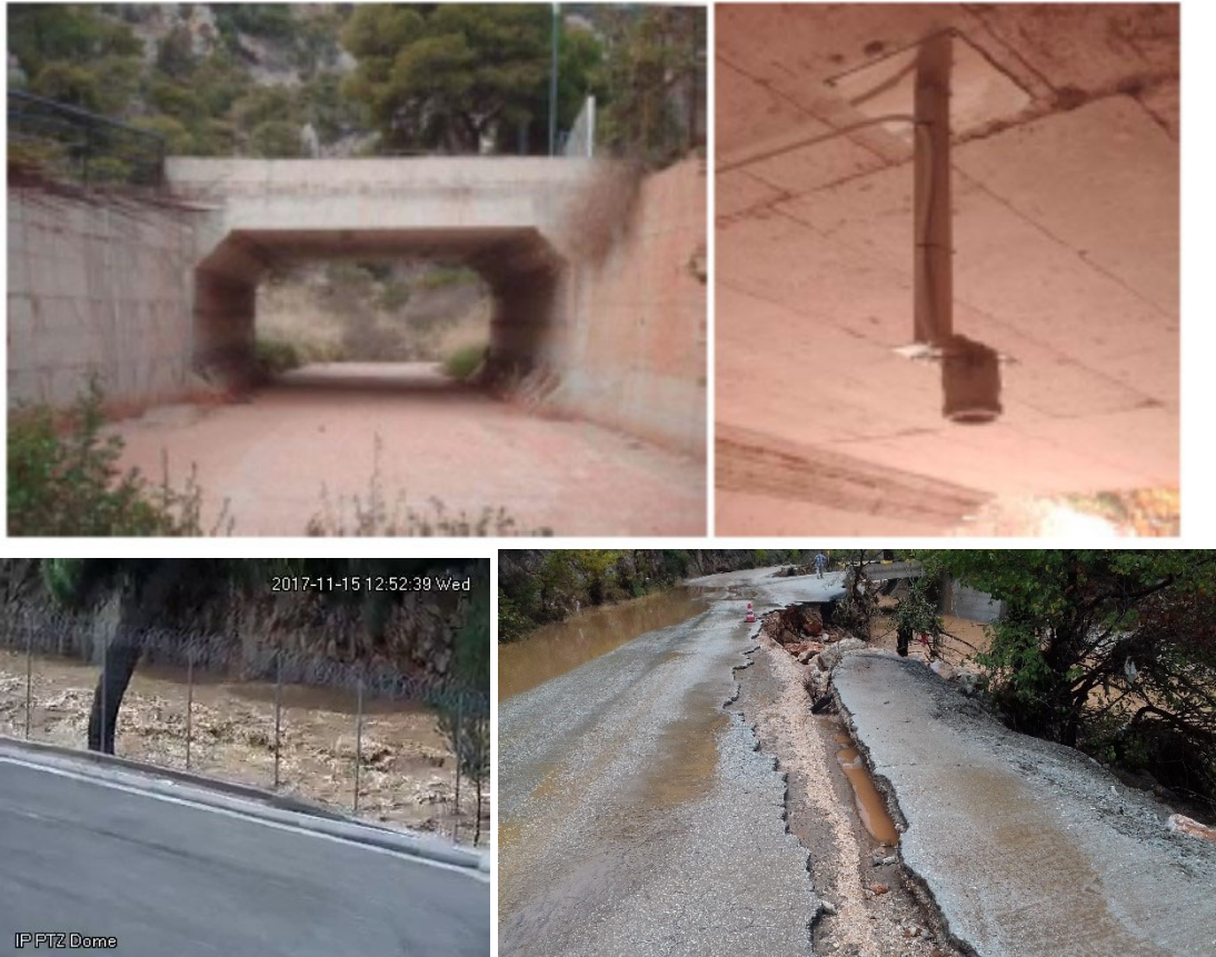
Εικόνα 16: Ο υδρομετρικός σταθμός στον Σαρανταπόταμο, θέση Γόρα Στεφάνης. Πάνω: Θέση και σταθμός (πριν την 15/11/2017), Κάτω: αριστερά η πλημμύρα, δεξιά η κοίτη αμέσως κατάντη του σταθμού στις 16/11/2017.
